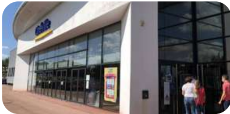
Rue François Cevert, 85000 La Roche-sur-Yon
